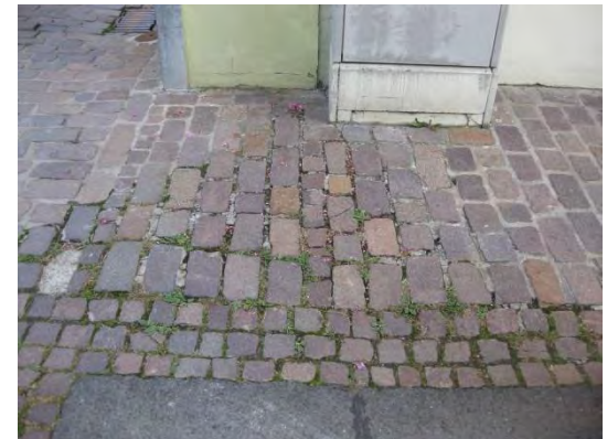
defekte Fugenfüllung
