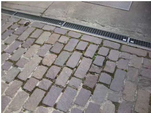
defekte Fugenfüllung
